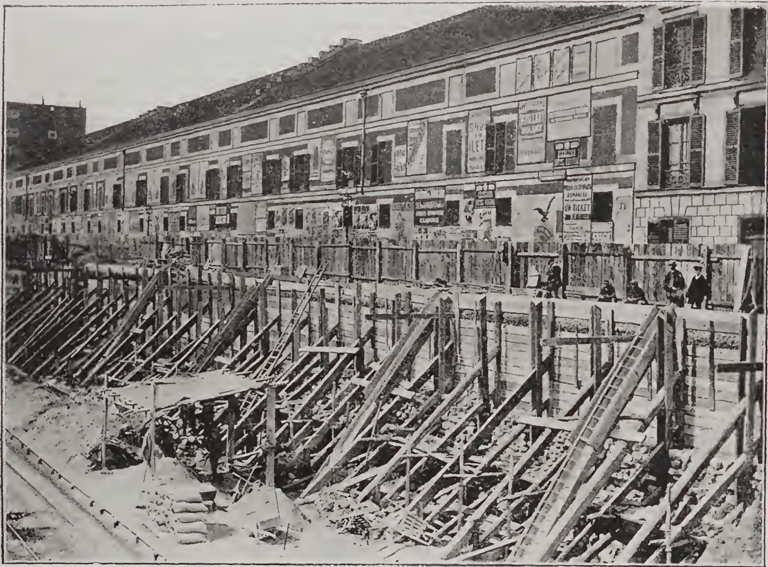
LA LIGNE COURCELLES-CHAMP-DE-MARS. — Mur de soutènement, entre les tunnels et le côté montant. Vue prise du pont des Ternes.
